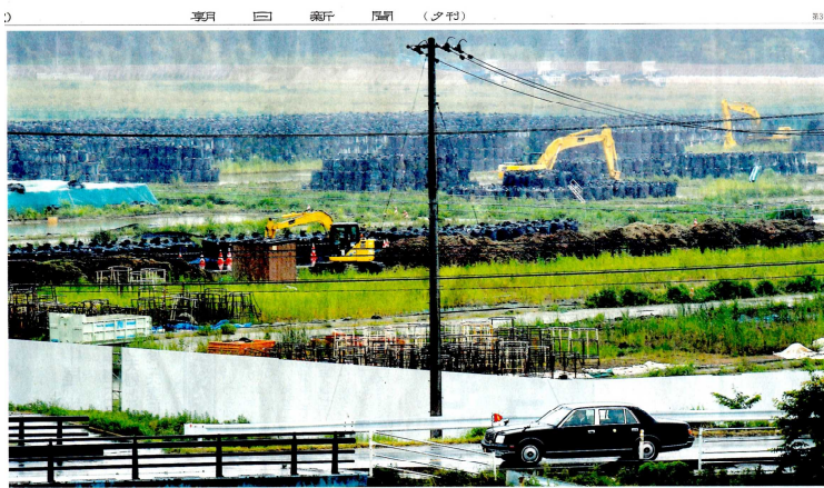
福島 北相馬市。福島県南相馬市に広がる除染土のフレコンバッグ
